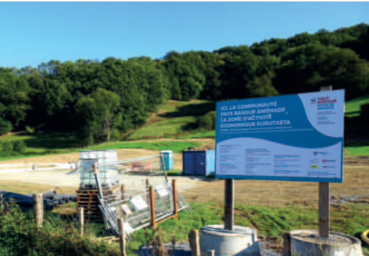
Chantier ZAE Kurutxeta
